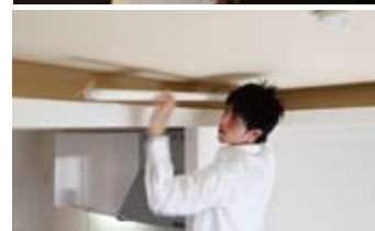
エコリカスタッフによる直管形LEDの設置。灯具の電源をOFFにしてから、口金と合わせ、場所を確認してセット。
